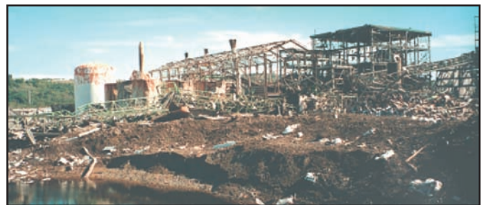
3. Conséquences de l'explosion de l'usine AZF (Toulouse, 2001) dans l'entourage immédiat de l'atelier.
